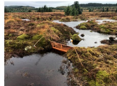
Argaeu pren a ddefnyddir fel rhwystr ar draws ffos coedwigo blaenorol, ger Nant Gwinau ar safle adfer mawndir ar dir fu gynt wedi ei goedwigo yng Ngheredigion, gyda'r bwriad o godi lefelau'r dŵr ar y mawndir amgylchynol.
